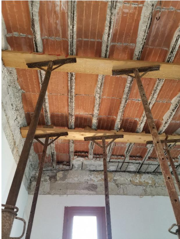
*Fig.14- Solaio in latero cemento: piano terzo.*
