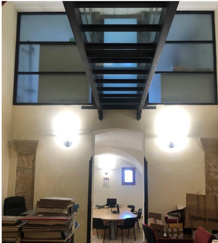
*Fig.6- Passerella in acciaio e vetro piano terra.*
